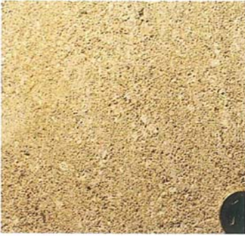
Abb. 256: Kalksandstein, Zogelsdorf- Formation, Zogelsdorf (Foto P. Ableidinger)
