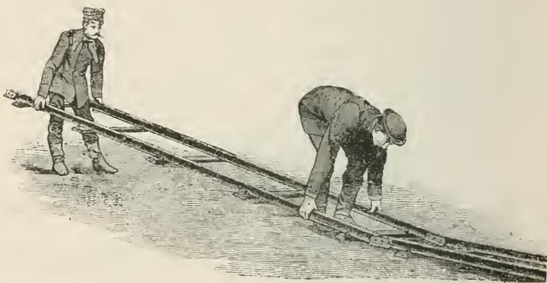
Fig. 877 und 878. Das Umlegen der Geleise bei kurzen und langen Geleisstücken.
