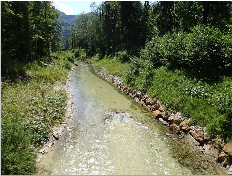
Abb. 12 Steil abfallende Ufer mit punktueller Blockwurfsicherung im unstrukturierten Oberlauf des Nebenarms Engleithen – Aufnahme bei Niederwasser.
