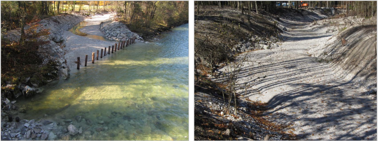
Abb. 4 Trockengefallener Einlaufbereich und Nebenarm im Oktober 2011.
