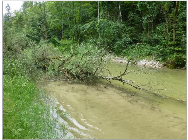
Abb. 9 Unterschiedlich strukturierte Uferbereiche. Links: Schotterbank mit großen Steinblöcken zur Erhöhung der Strömungsdiversität. Rechts: Sandablagerungen im Strömungsschatten eines Raubaumes.
