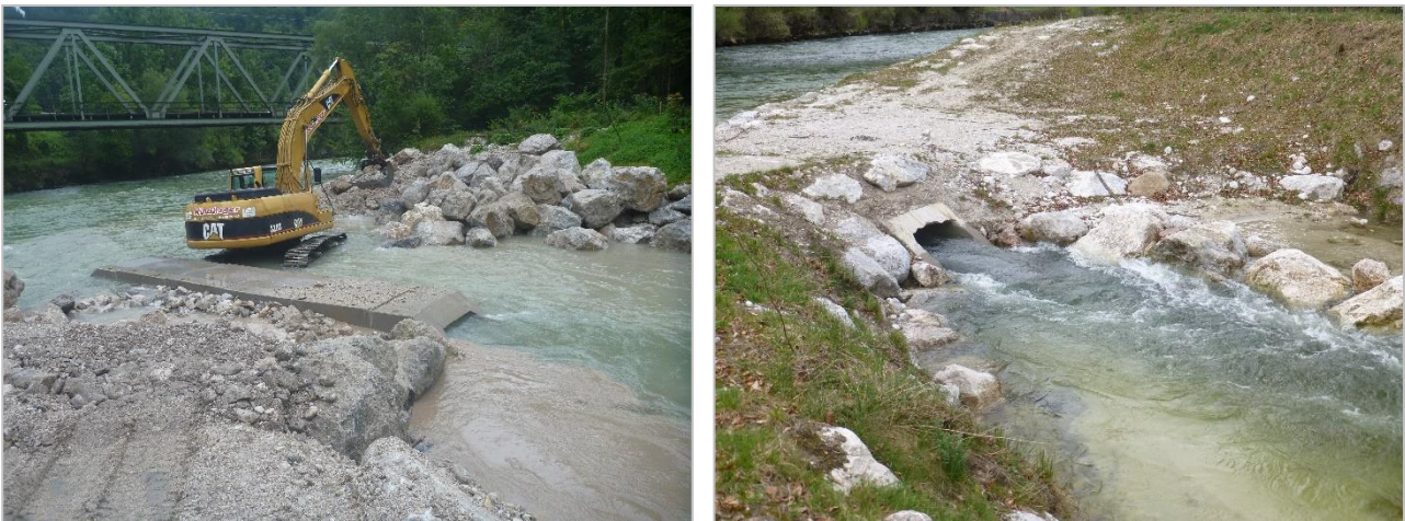
Abb. 6 Links: Errichtung des Einlaufbauwerks und des Damms. Rechts: Fertiggestelltes Bauwerk.
