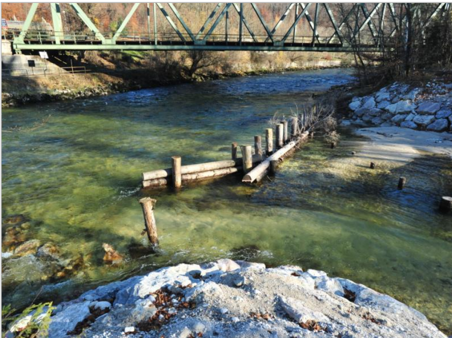
Abb. 3 Erste Adaptierung im Einlaufbereich.
