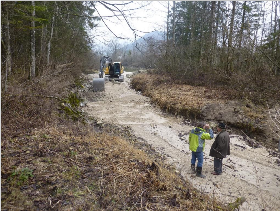
Abb. 2 Herstellung des Nebenarm-Oberlaufs.
