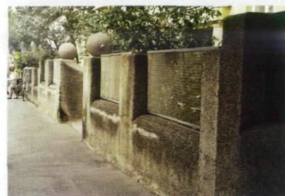
Abb. 20: Grillparzerstraße 6: Metall-Betonzaun zur Begrenzung (Foto: U. Sigmund)
