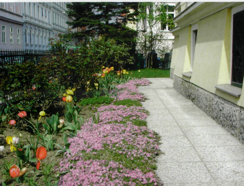
Abb. 3: Schillerstraße 25: Platten zum Schutz des Hauses vor Feuchtigkeit
