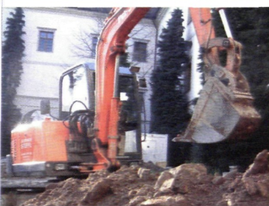
Umbauarbeiten am Schlossmuseum, Foto: OÖLM
