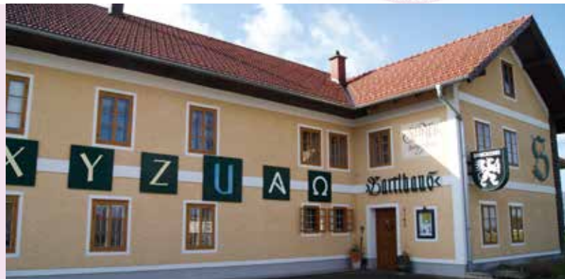
Außenansicht des Bartlhaus
