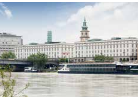
Die beiden Brückenkopfgebäude
