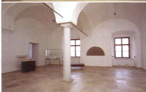
Raum 1/7 (Kunst der Donauschule) während und nach den Bauarbeiten Fotos: A. Bruckböck
