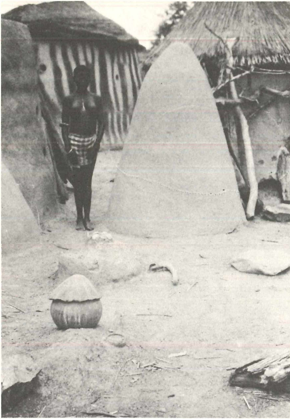
Abb. 4: Eingang eines Gehöftes der Ost-Kassena in Kaya (Cercle P6). Der Konus rechts ist wie die Mauer links mit einigen Löchern versehen, die der Aufnahme der Balken zum Verschließen des Eingangs dienen. Neben dem Konus ist die Mauer offenbar verfallen. Aufnahme: Zwerne- mann, 1955
