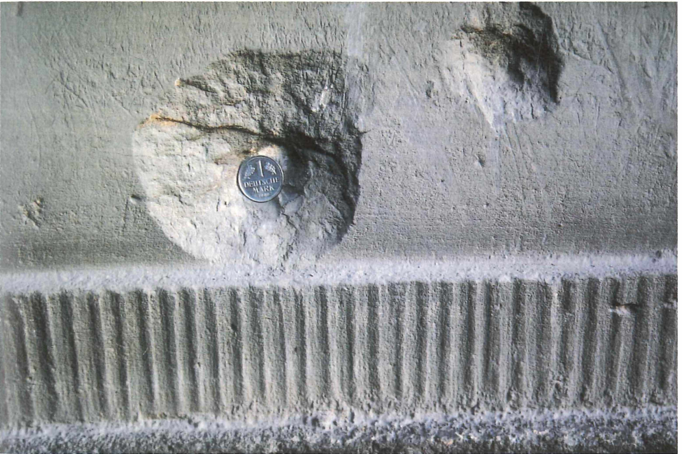
Abb. 4. Kraterartige Einschlagsmarken von Bombensplittern in der Sandsteinfassade auf der Westseite des Reichsgerichts in Leipzig. Foto: 1. 1. 1998
