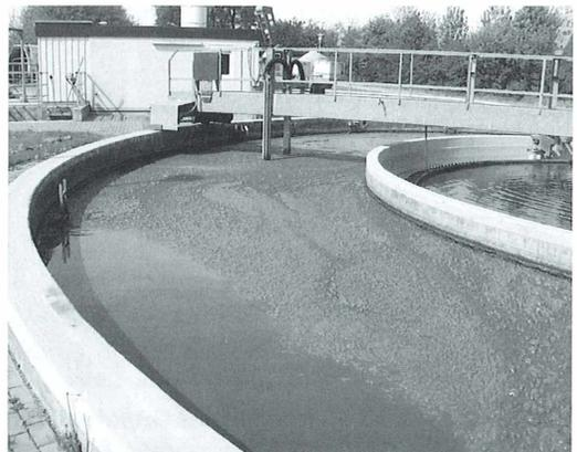
**Abb. 1: Belebtschlammbecken einer Kläranlage mit Schaumbildung.**
