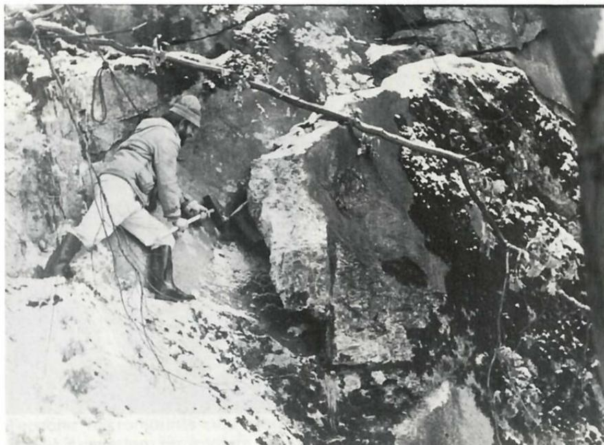
Abb. 2: Die Arbeit im Bruch ist schwierig und kräfteraubend; hier beim Abkeilen eines größeren Blockes des gut sichtbaren Pegmatit-Ganges.
