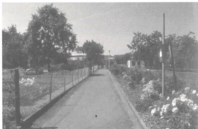
Foto 2: Ein Beispiel für eine Wegefläche, auf der das Niederschlagswasser nicht in die Seitenräume fließen kann, sondern über die Oberflächenentwässerung abgeführt wird und so für die Grundwasserneubildung verloren ist.
