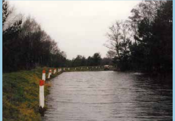
Wasserrückhalt am Damm bei Bockheber. Der Damm verhinderte, dass Oberflächenwasser von den militärisch genutzten Flächen ins Bockheberer Moor gelangt (ca. 1980).
