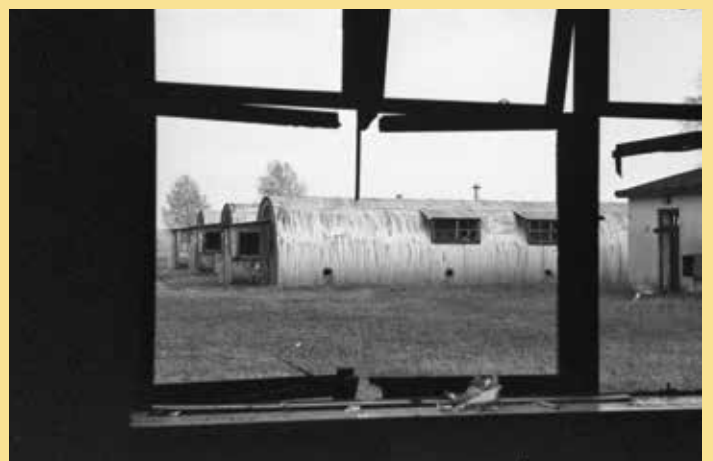
Ein künstlerisch anmutender Blick auf die Nissenhütten, 1998 dokumentiert.
