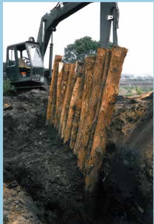
Eichenstämmen wurden in den Boden gerammt, um die Böschung an den neuen Panzerüberfahrten zu sichern (ca. 1980).
