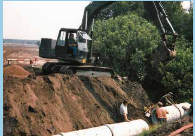
Verrohrung der Brunau für Panzerüberfahrten (ca. 1980).
