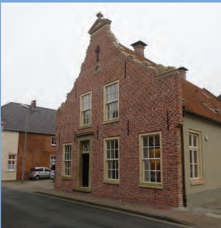
Abbildung 8: Denkmalgerechte Restaurierung des Privathaus der Familie Hesse in Weener
