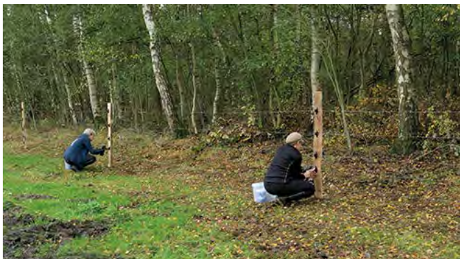
Abb. 3: Unterstützung beim Bau eines wolfsabweisenden fünfreihigen Elektro-Festzaunes durch Ehrenamtliche © Peter Schütte
