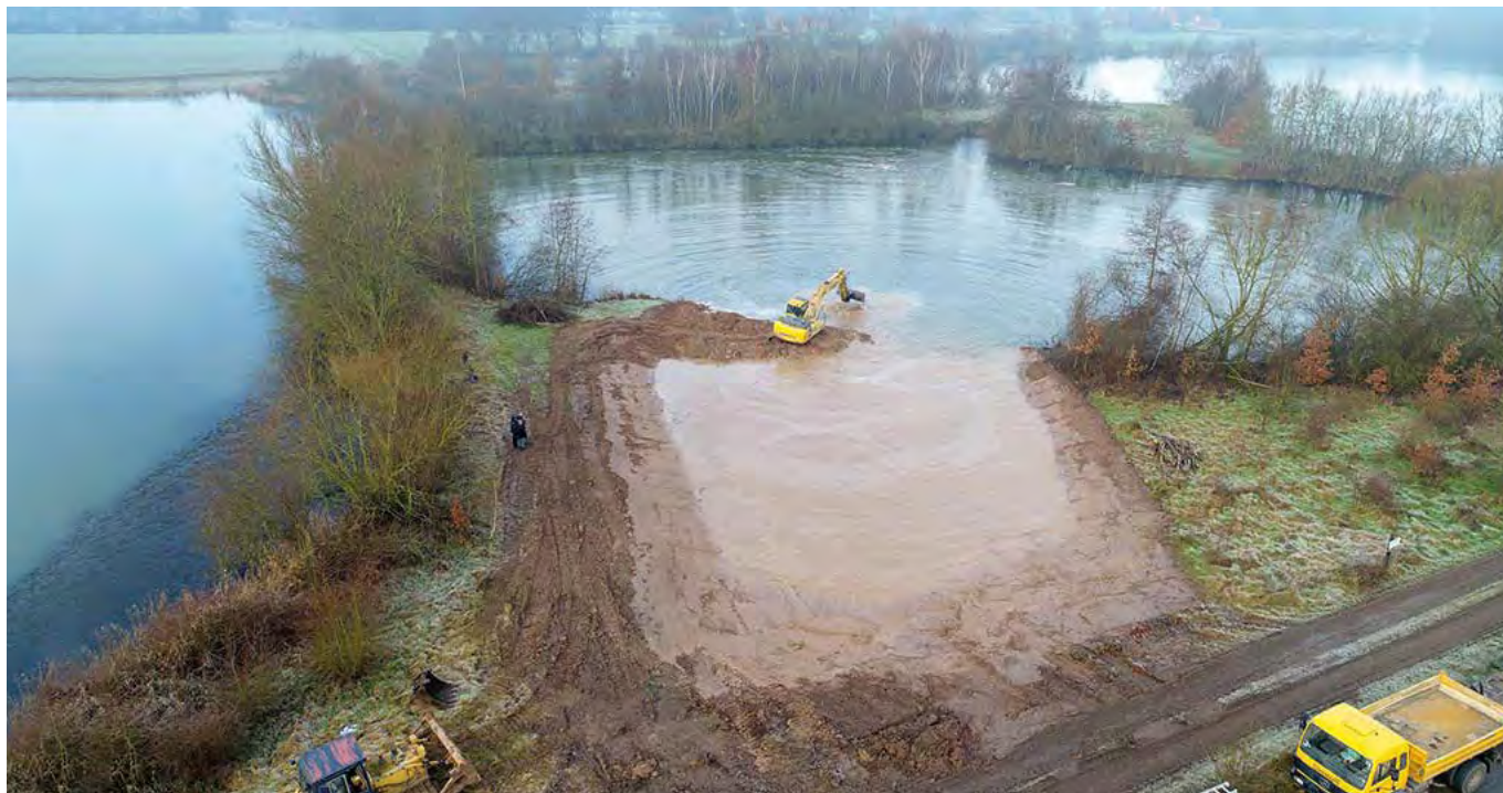
Abbildung 2: An vier steilscharigen Baggerseen wurden zusätzlich zum Totholzeintrag Flachwasserzonen neu angelegt und an die Gewässer angeschlossen. © Th. Klefoth
