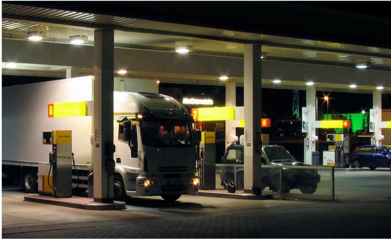
Abb. 1: Dachkonstruktion der LKW- und PKW-Tankstelle auf dem Autohof Mendig an der A61. Von leicht schräg gestellten Strahlern wurden Käfer angelockt.
