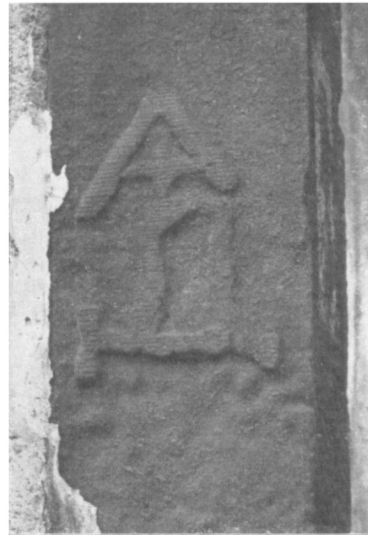
Fig. 3. Rechter Torpfeiler Aussenseite.
