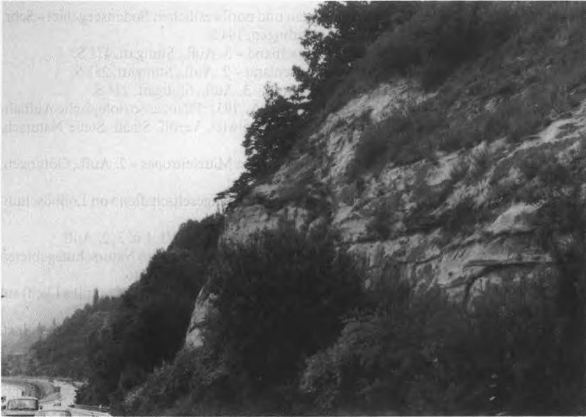
Fig. 1: Beim Straßenbau angeschnittener Steilhang in der Oberen Meeresmolasse bei Brunnensbach am Bodensee.
