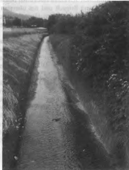
Fig. 3: Zähringer Dorfbach (ZÄH), vollständig vom natürlichen Untergrund abgeschnitten durch Pflastersteine und Betonschalen, außerdem häufiger Wechsel im Wasserstand bis zum Trockenfallen. Dieses zur Abflusssrinne degradierte Fließgewässer ist entsprechend artenarm.
