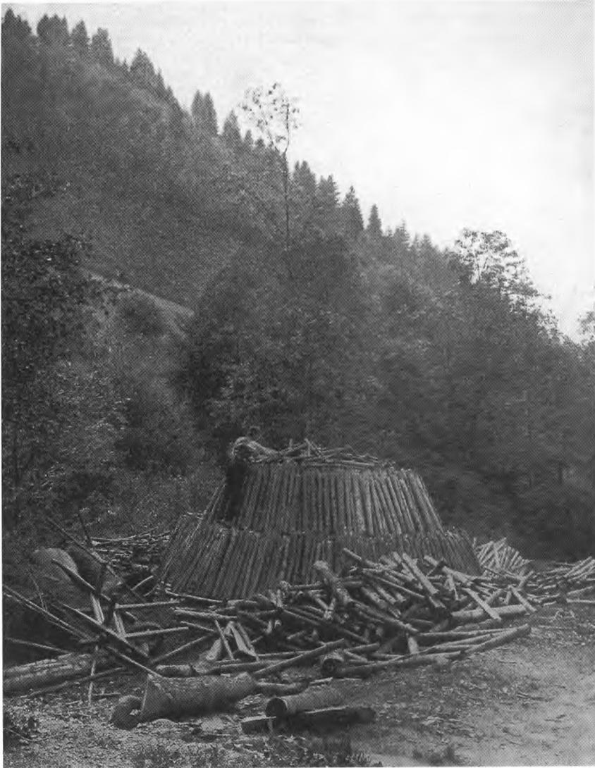
Abb. 6: „Bau eines Kohlenmeilers im Zastler Tal. Nach einer Photographie von M. Ferraris in Freiburg“.
