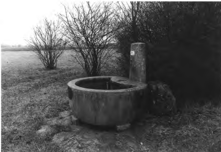
Abb. 3: Auslaufbecken der Bahlinger Mineralquelle (Foto: W. Käss, 18.12.1997).
