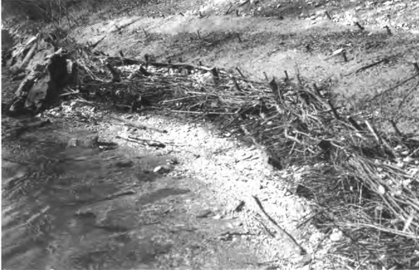
Abb. 5: Ersatz der ehemaligen Uferverbauung an der Birs durch ingenieurbologischen Lebendverbau. (Foto: Urs Zeller)
