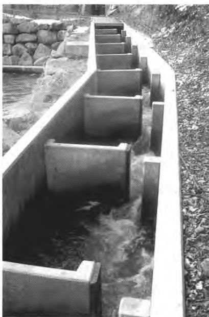
Abb. 3: Schlitzpass für Lachse am Kraftwerk „Neue Welt“ in der Birs bei Münchenstein. (Foto: Urs Zeller)
