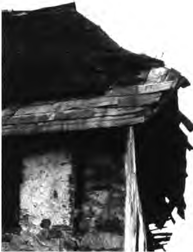
Abb. 2: Der alte Klausenhof mit gut sichtbarer abgerissener Ostgiebelwand.
