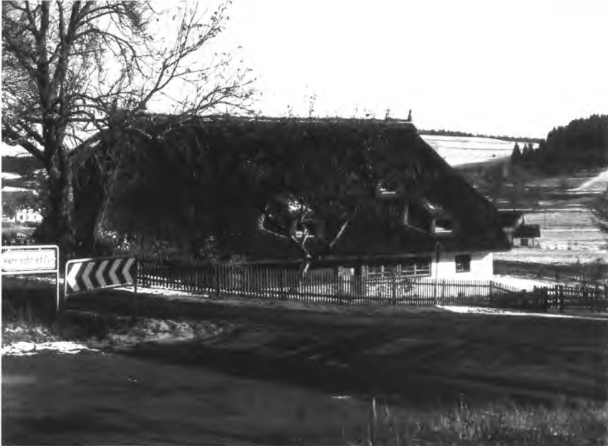
Abb. 11: Außenansicht des Klausenhofes (Südseite) nach der Fertigstellung 1980.
