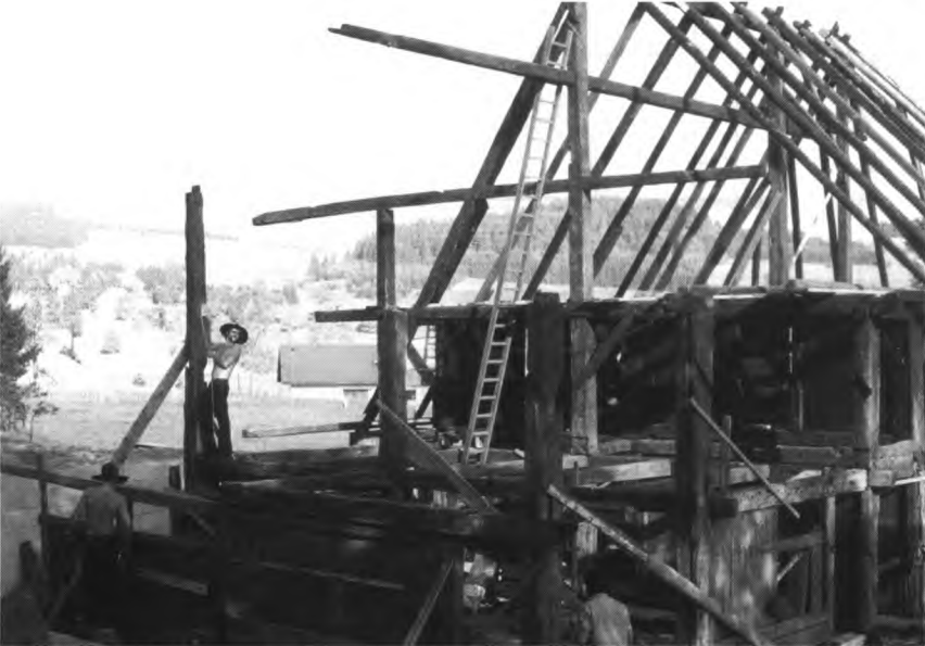
Abb. 6: Neuaufrichtung des Dachgeschosses.
