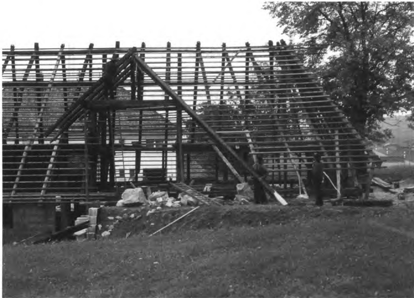
Abb. 8: Aufgerichteter Dachstuhl mit 'Ifahrhüsl' an der Nordseite.
