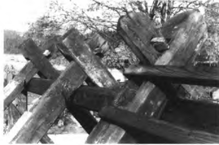
Abb. 7: Ausschnitt der Firstkonstruktion (Rafen). (Foto: Verf., 1979)
