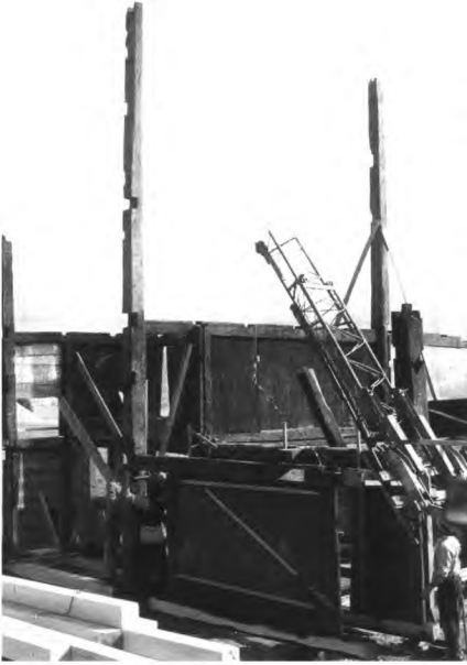
Abb. 5: Wiederaufrichtung der Hoch- und Firststuden. (Foto: Verf., 1979)
