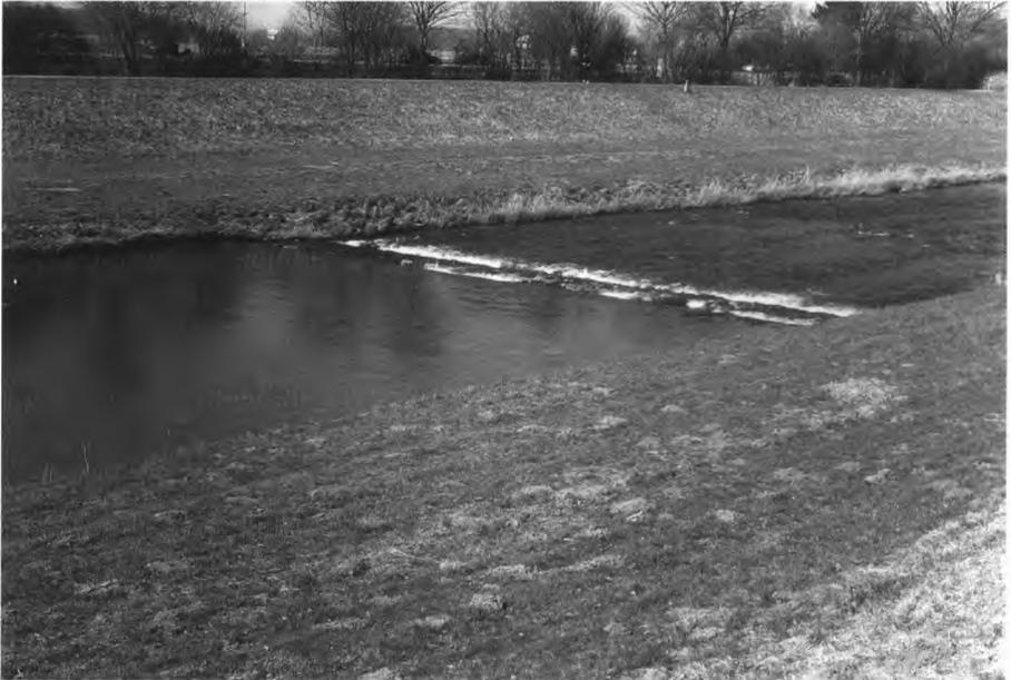
**Abb. 7:** An der Probenstelle Emmendingen ist der Lauf der Elz ist durch hohe Uferdämme vorgegeben; das Flussbett selbst ist mit Stein- und Betonplatten verkleidet und mit Sohlswellen versehen. Es kommt zu einer gleichmäßigen Fließgeschwindigkeit bei einheitlichem Wasserstand.
