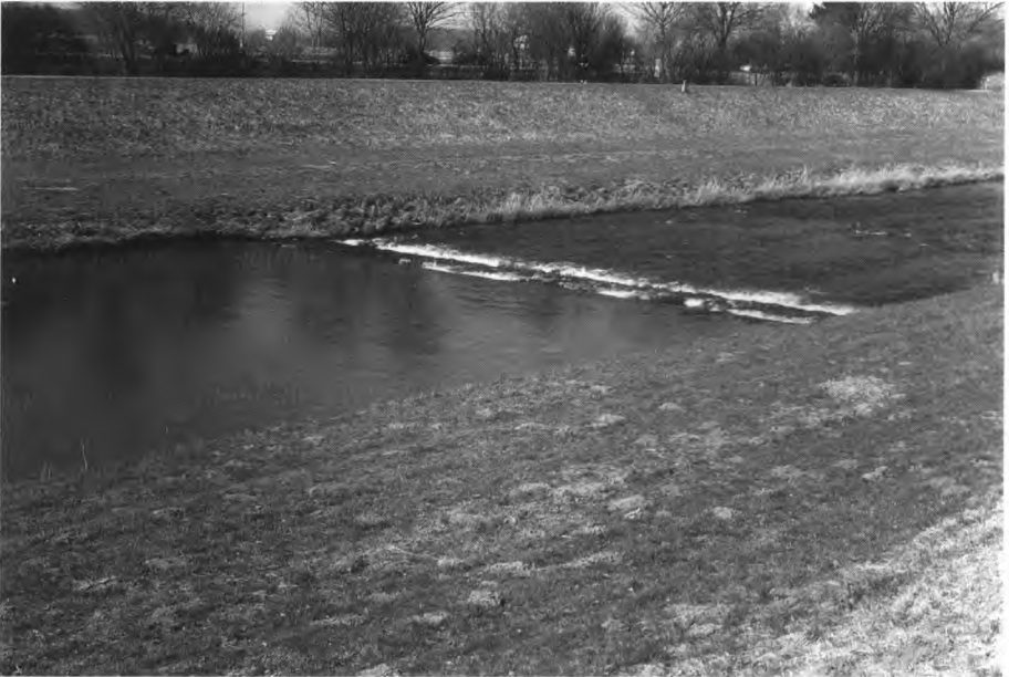
Abb. 7: An der Probenstelle Emmendingen ist der Lauf der Elz durch hohe Uferdämme vorgegeben; das Flussbett selbst ist mit Stein- und Betonplatten verkleidet und mit Sohlswellen versehen. Es kommt zu einer gleichmäßigen Fließgeschwindigkeit bei einheitlichem Wasserstand.
