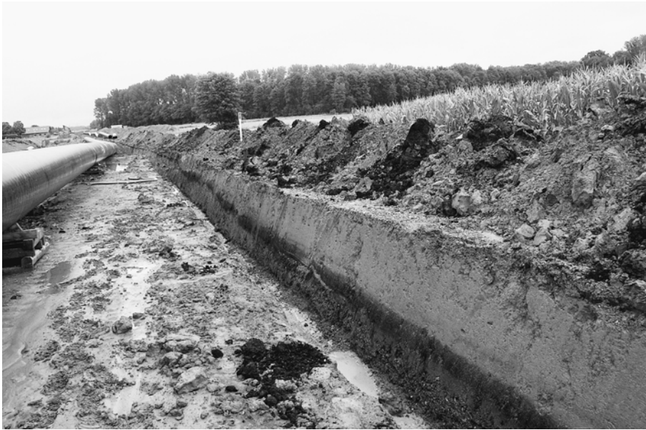
Abb. 4: Trasse der TENP-Pipeline am Blankenberg (Freiburg-Tiengen). Der Aufschluss zeigt Schwarzwaldschotter überlagert von Kolluvium am Hangfuß des Blankenbergs (August 2002).
