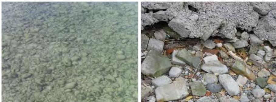
**Abb. 6:** Erosion am Bodenseeufer. Links: natürlich entstandenes Geröllpflaster, die kleinen dunkelgrauen Flecken sind Kolonien von Dreikantmuscheln (Konstanz, Südufer der Insel Mainau, 16.08.2013, Foto: Verf.). Rechts: Mauersockel mit leichter Unterspülung des mit Beton vergossenen Bauschutts, im Vordergrund Reste von Ziegelschutt, der als Hinterfüllung gedient hat (Berlingen, Kt. TG, 13.03.2011, Foto: Verf.).
