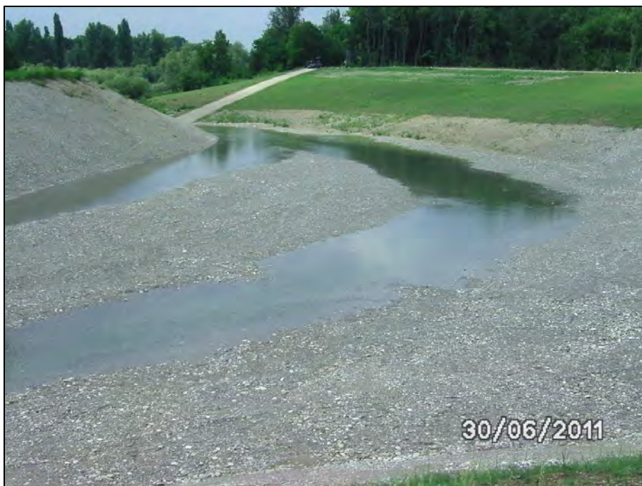
Abb. 2: Erste Überflutung der im April 2011 fertiggestellten Teilfläche 3.1 am 30.06.2011; Blickrichtung flussabwärts. Die Aufnahme entstand bei beginnender Einflutung über die im Bild nicht sichtbare, am oberen linken Bildrand gelegene Einströmöffnung am Rhein. Bei diesem Wasserstand gut erkennbar ist die Feinreliefierung der Tieferlegungssohle. Zwischen der Schlut (-35 cm über mittlerem Auskiesungsniveau, rechts im Bild) und der Senkenfläche (-20 cm, links im Bild und entlang des Leinpfaddamms verlaufend, der nach 2015 ebenfalls noch tiefergelegt werden wird) liegt eine Wallfläche (+20 cm). Die an natürlichen Auenverhältnissen orientierte Feinreliefierung soll eine möglichst rasche Gehölzbesiedlung der Tieferlegungsfläche sicherstellen (Foto: R. Zimmermann).
