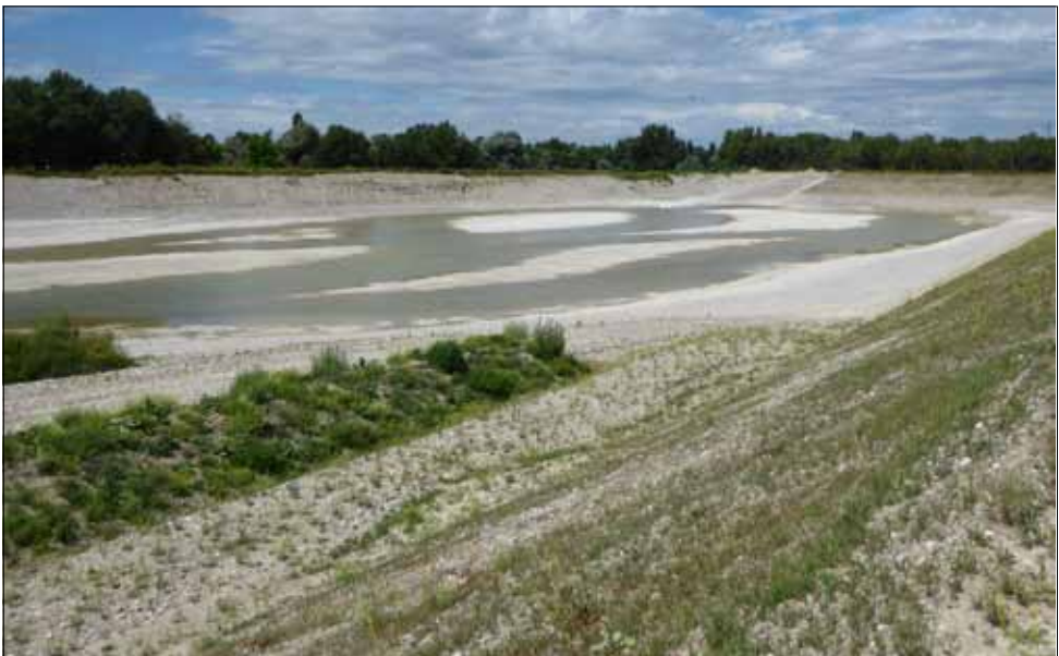
Abb. 6: Hoher Grundwasserstand im August 2016 lässt die Konturen des Wall-Senken-Systems der Weidenaue in der Teilfläche 12 Mitte deutlich hervortreten. Zu diesem Zeitpunkt der Bauunterbrechung fehlte noch der direkte Anschluss an den Rhein, so dass flussseits keine Überflutung erfolgen konnte. Die Ansiedlung der Deutschen Tamariske dürfte während dieser Phase erfolgt sein. Foto: © Reinhard Zimmermann.
