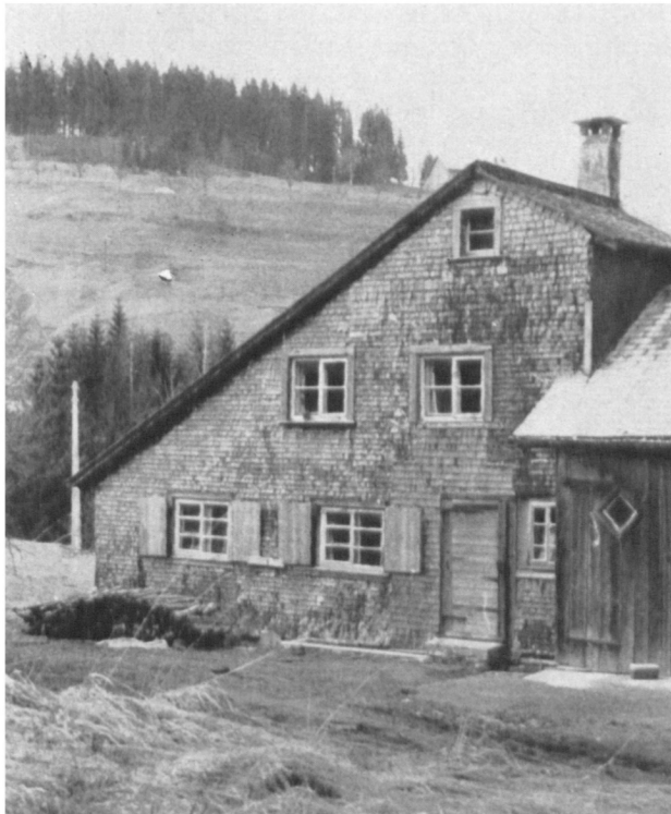
Fig. 2: Rückseite der Hydrobiologischen Station Falkau mit den Fenstern der Arbeitsräume für Limnochemie (unten), Limnobotanik (Mitte links) und Grundwasserforschung (Mitte rechts).
