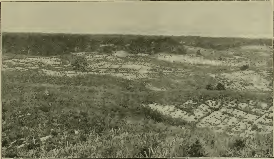
Dünenaufforstung in viereckigen Reisig-Bestecken.
