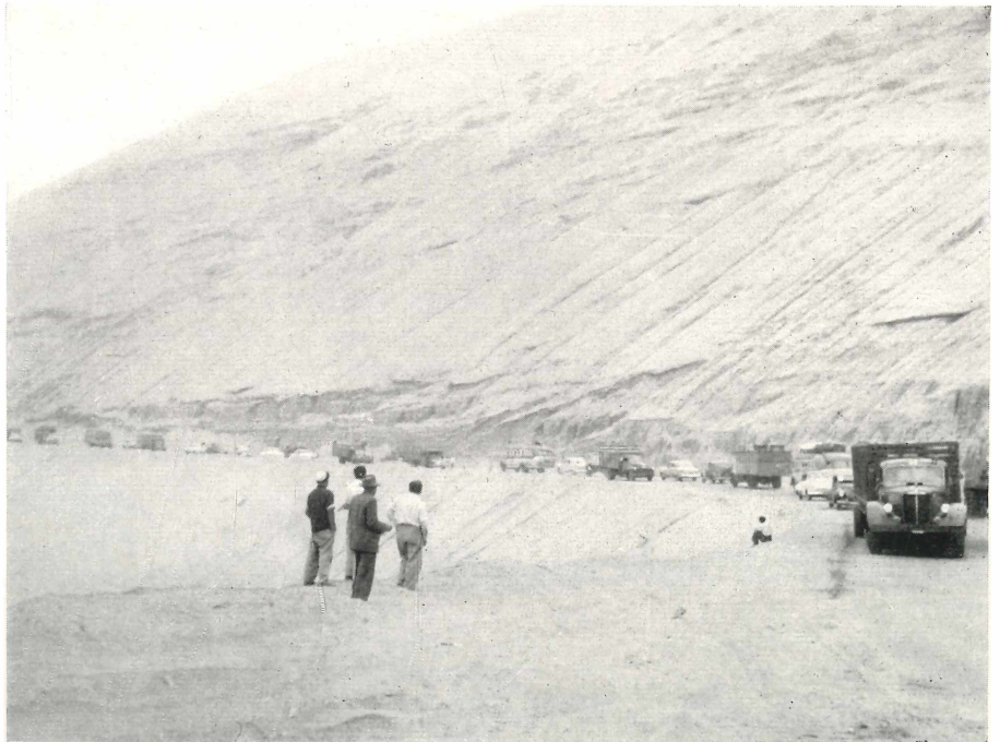
Bild 2. Die panamerikanische Straße zwischen Ancón und Chancay, Pasamayo-Strecke, in einem zum Meere abfallenden Dünenhang angelegt.
