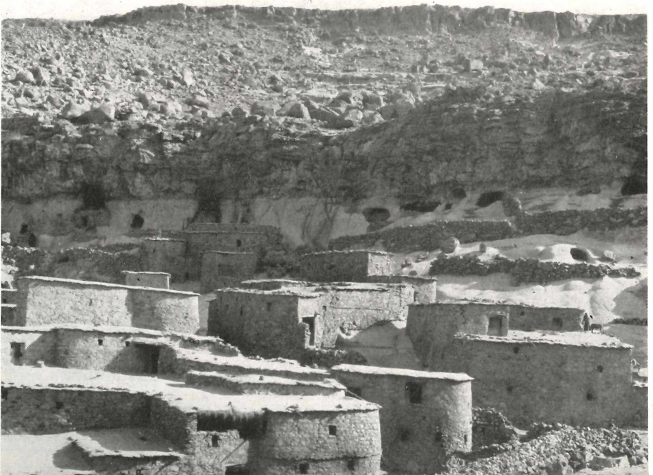
Bild 4. Mächtige Blocklava über jungtertiären, terrigenen Sanden und Tonen mit z. T. bewohnten Höhlen. Im Vordergrund das Berberdorf Ameur, erbaut aus luftgetrockneten Erdziegeln.
