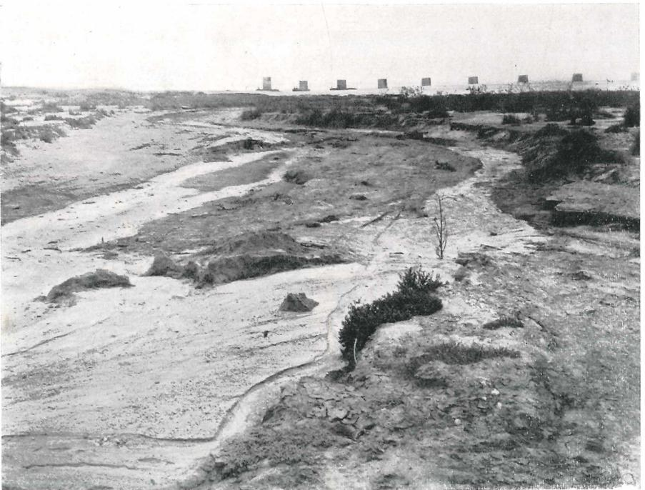
Bild 5. Swakopriver vor der Mündung; im Hintergrund die noch stehengebliebenen Pfeiler der durch das Hochwasser 1934 zerstörten alten Eisenbahnbrücke. Aufn. SPREITZER, 3. 10. 1961.
