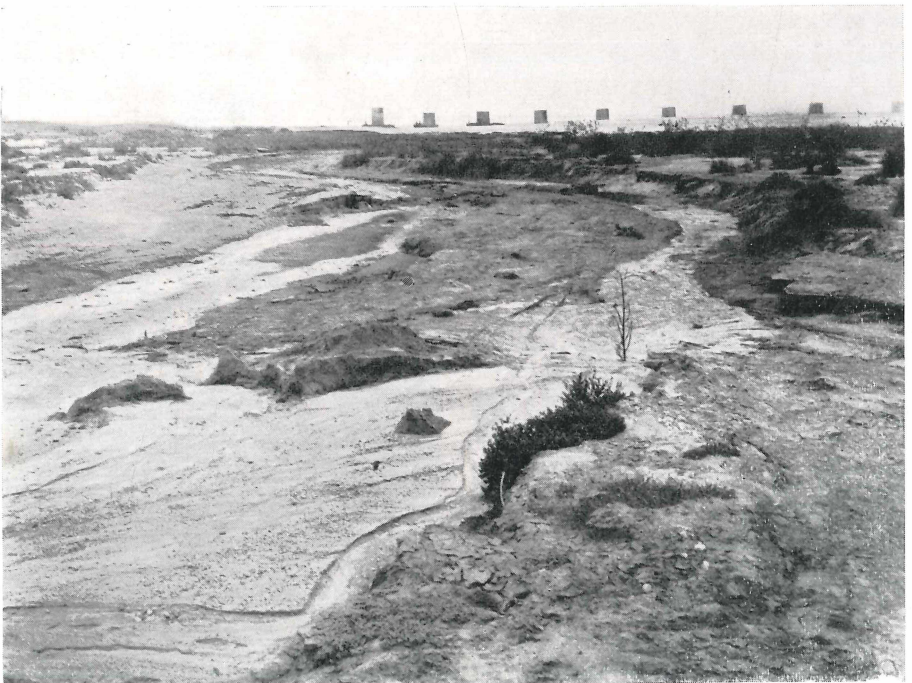
Bild 5. Swakopriver vor der Mündung; im Hintergrund die noch stehengebliebenen Pfeiler der durch das Hochwasser 1934 zerstörten alten Eisenbahnbrücke. Aufn. SPREITZER, 3. 10. 1961.
