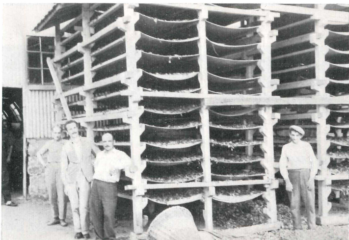
Bild 7. Teeverarbeitungsbetrieb in Hopa. Holzgestelle für das Welken der frischgepflückten Blätter (August 1961).
