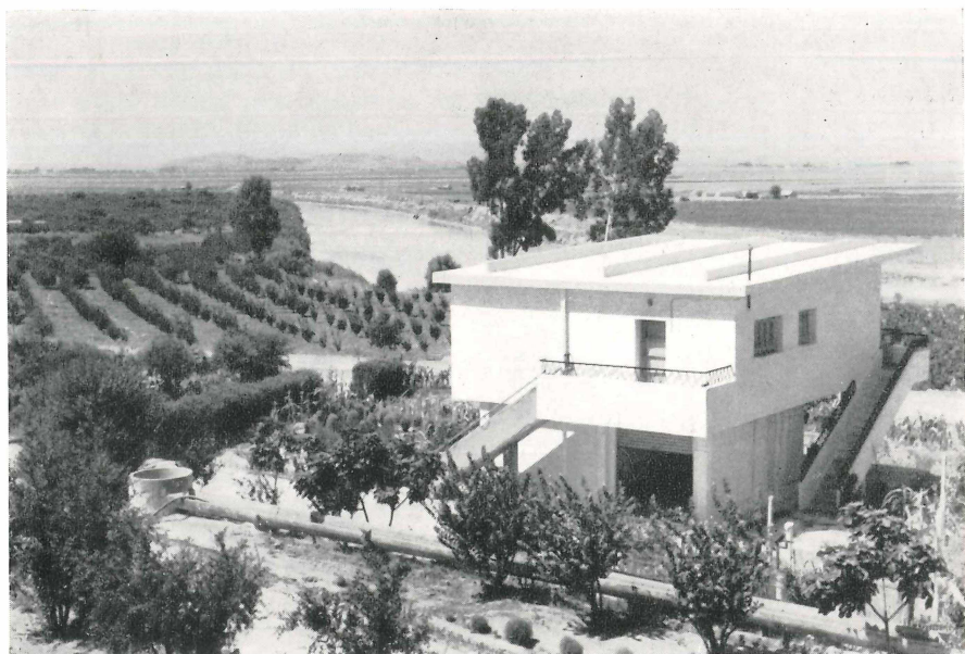
Bild 1. Mündungsgebiete der Medjerda. Bewässerte Obstbaumpflanzungen im Bereiche der Pumpstation Sidi Tabet.
