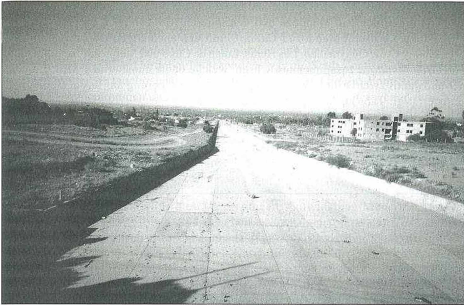
Abb. 7: Der 'Zanjón Papagayos', einer der vier großen die Stadt durchziehenden Betonläufe, die, der Gefällsrichtung des Pediments folgend, die auf diesem oberhalb der Stadt bei Starkregen anfallenden Wasser- und Schuttmassen gezielt ableiten sollen. In der Ferne sind die Weiten der den Anden vorgelagerten 'Llanura' zu erkennen
