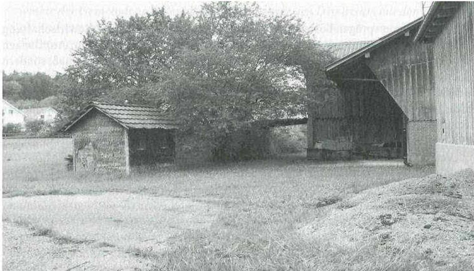
Abb. 2: Alter Bauernhof im dicht besiedelten Wohnquartier (Foto: FELBER RUFER 2004)
