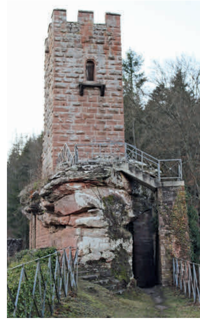
Abb. 3: Ansicht von Osten.
