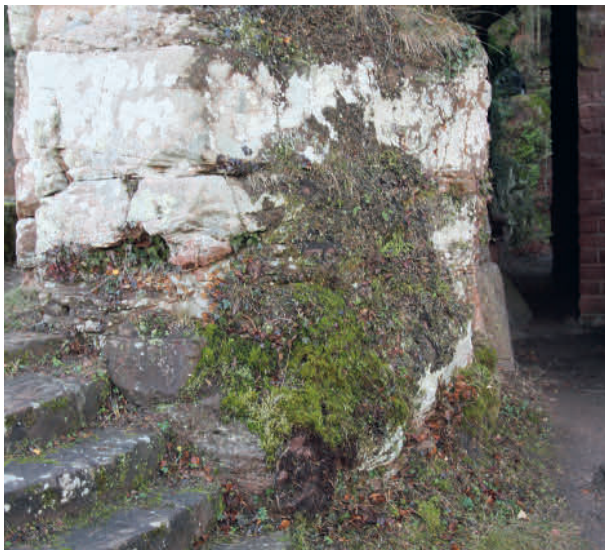
Abb. 12: Innenbereich der Burg nach einer Pflegemaßnahme, bei der lediglich Gehölze entfernt wurden und sensible erdbedeckte Bereiche geschont blieben.
