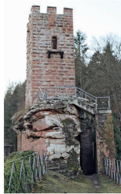
Abb. 3: Ansicht von Osten.
