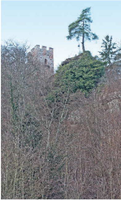
Abb. 1: Ansicht des Burgfelsens mit der Burgruine Erfenstein aus Südosten.
