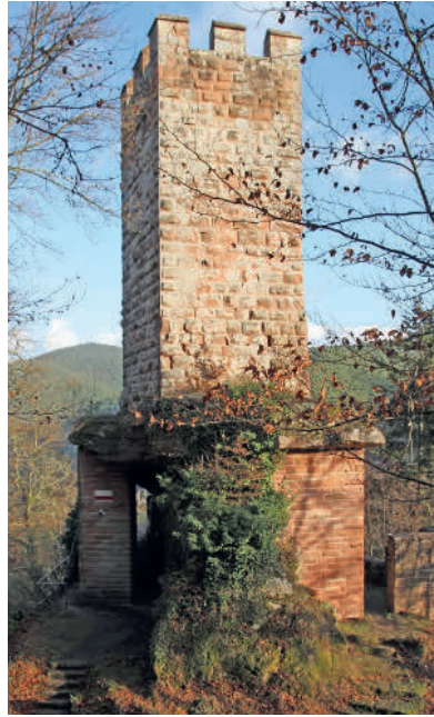
Abb. 2: Ansicht der Burg von Westen.
