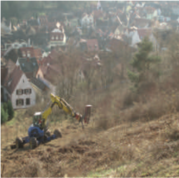
Abb. 4: Mit dem Schreitbagger wurden die steilen Hangbereiche freigestellt. (28.2.2011; Foto: M. KITT)
