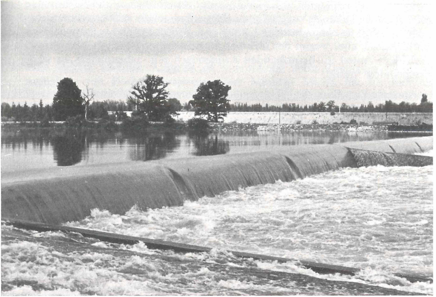
Abb. 1: Der Ausbau des Oberrheins im Bereich zwischen Breisach und Straßburg (hinten die Kanalschlinge). Für die Auewälder sind teilweise Grundwasserabsenkungen, teilweise auch verstärkte Überflutungen die Folge.
