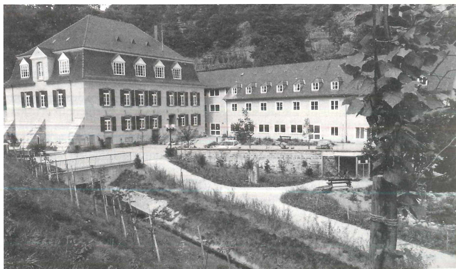
Abb. 1: Pfalzmuseum für Naturkunde (POLLICHIA-Museum) in Bad Dürkheim: Gesamtansicht mit Teilen der Außenanlage.
