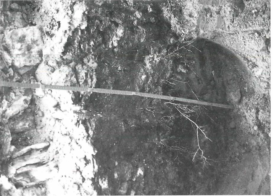
Abb. 5: Substrataufbau unter der Straße
