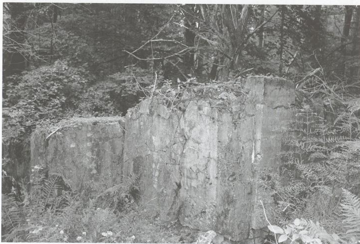
Abb. 8: Bu4, Bunkerruine im Bienwald, Zustand im Sommer 2006 (Foto: O. Röller).
