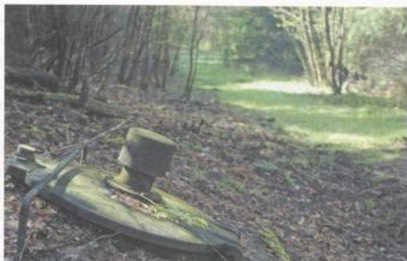
Abb. 14: Ein gusseiserner schwarzer Deckel signalisiert den Beginn der unterirdischen Sickergalerie, aus der in der Quellkammer mit einem starken Rohr das Wasser der Lauter stadtwärts geleitet wird. (Foto 21.04.2005)
