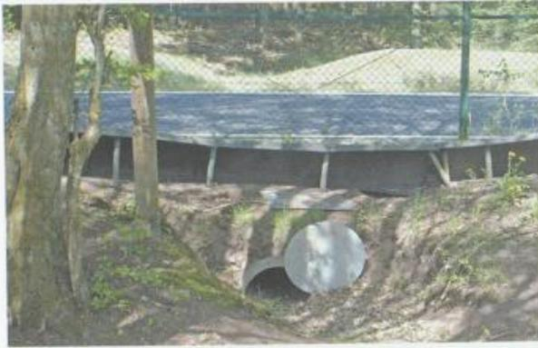
Abb. 20: Südlichste der vier Doppelröhren-Tunnelanlagen unter der L 504 hindurch, von der Teichseite aus. Das System wiederholt sich jenseits der Straße spiegelbildlich für die Leitung der Laichwanderung im Frühjahr. (Foto 04.05.2006)
