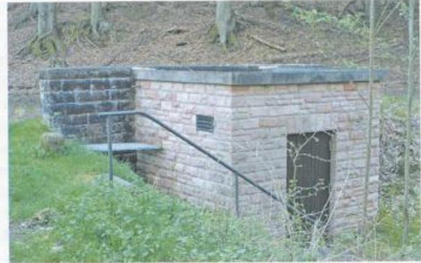
Abb. 4: Aus der Quellkammer der Lauter, der „Lauterspring“, wird das Wasser der gut 100 m langen gemauerten Sicker-galerie abgeführt. (Foto 04.05.2006)
