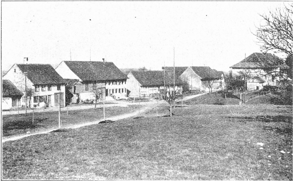
Abb. 6. Miesenried (Thurtal): Verstärkte, „blinde“ Mauerwände. (Schutz gegen den Westwind.) Reihenstellung der Häuser in Windrichtung.
