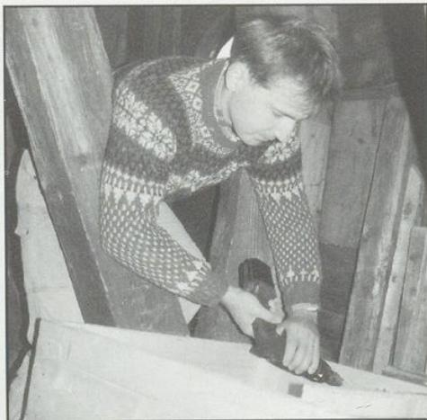
A. Häußler beim Anbringen eines Nistkastens. Dieser wird mit Kreuzschlitzschrauben (Einsatz des Akku-Schraubers) direkt hinter dem Einflug befestigt, was den problemlosen Ab- und Anbau bei Reparaturen am Gebäude ermöglicht.
