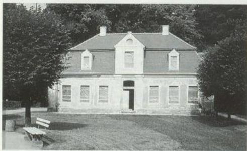
Abb. 4. Der Herren- oder Vogelschutzpavillon vor dem Alten Schloß in Neschwitz. Zustand im Herbst 1997 nach der Wiederherstellung von Dach und Obergeschoß. – Foto: HANS CHRISTOPH STAMM.
