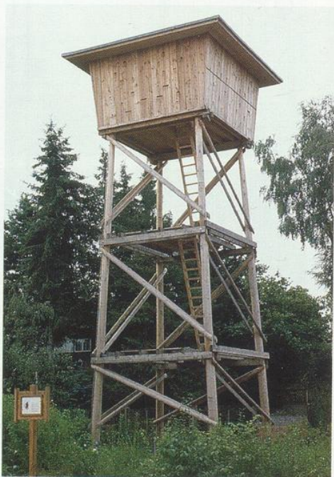
Mauerseglerturm im ÜAZ, Glauchau/ Lungwitzer Str.
