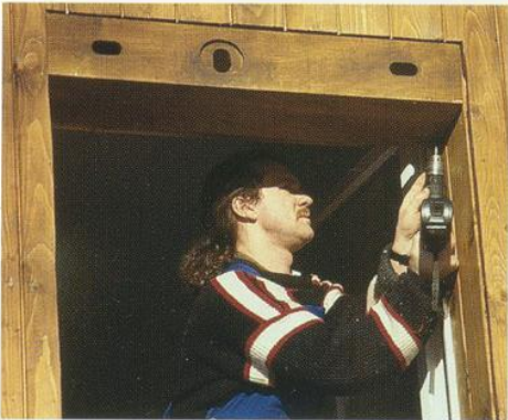
Oben: Jalousie-Nistkasten an einem Wohngebäude, Leipzig/Paul-Küstner Str. 16. Foto: F. HENSEN. Unten links: Nachträgliche Montage eines Jalousie-Nistkastens, Chemnitz/Adelsbergstr. 192. Unten rechts: Blumennistkasten, Chemnitz/Annaberger Str. 93.
