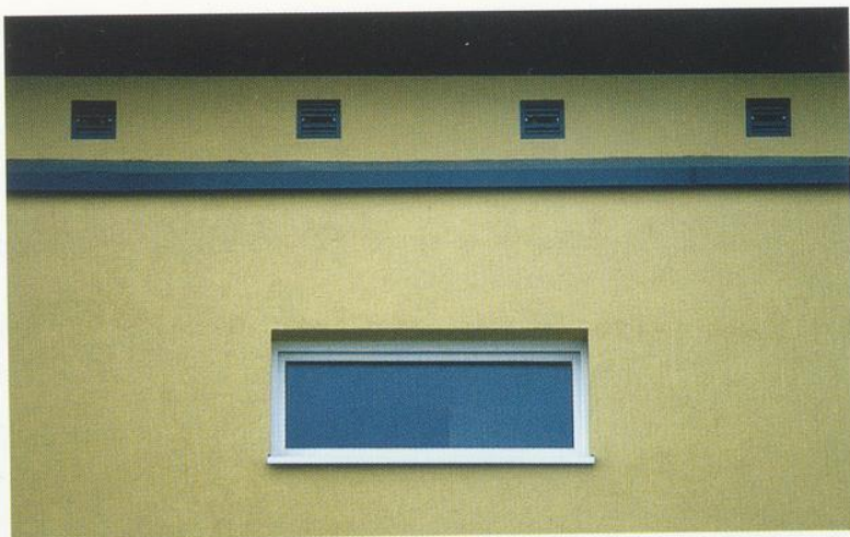
Einflugsöffnungen im Drempebereich, Chemnitz/Brückenstr. 23
