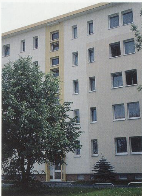
Saniertes Wohnblock (Q6/IW67) mit WEDI-I-Nistkasten, Chemnitz/ Geibelstr. 121.
