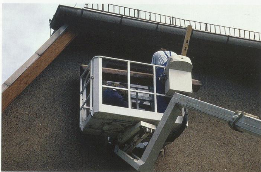
Montage eines Nistkastens mit Hilfe einer Hubbühne.
